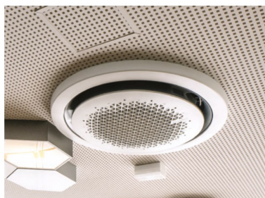
Montáž v podhledu
